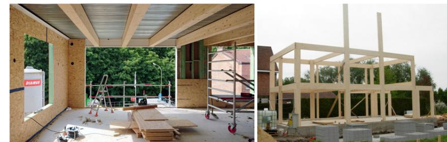
Referentie links: Cohousing De Sijs in Leuven, door OFFICEU architects. Referentie rechts: een 3d-grid als dragende structuur uit houten balken en kolommen. Alle gevels en binnenwanden zijn niet-dragend.
