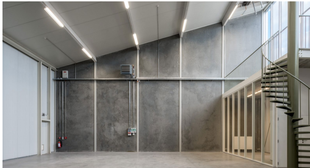
Referentie: HP engineers - 't Werkpand te Waregem samen met Office Geers - beheerst integreren van technieken in opbouw
