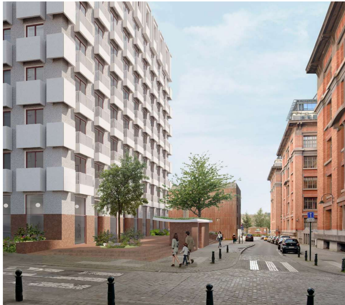
Zicht op het nieuwe voorplein
