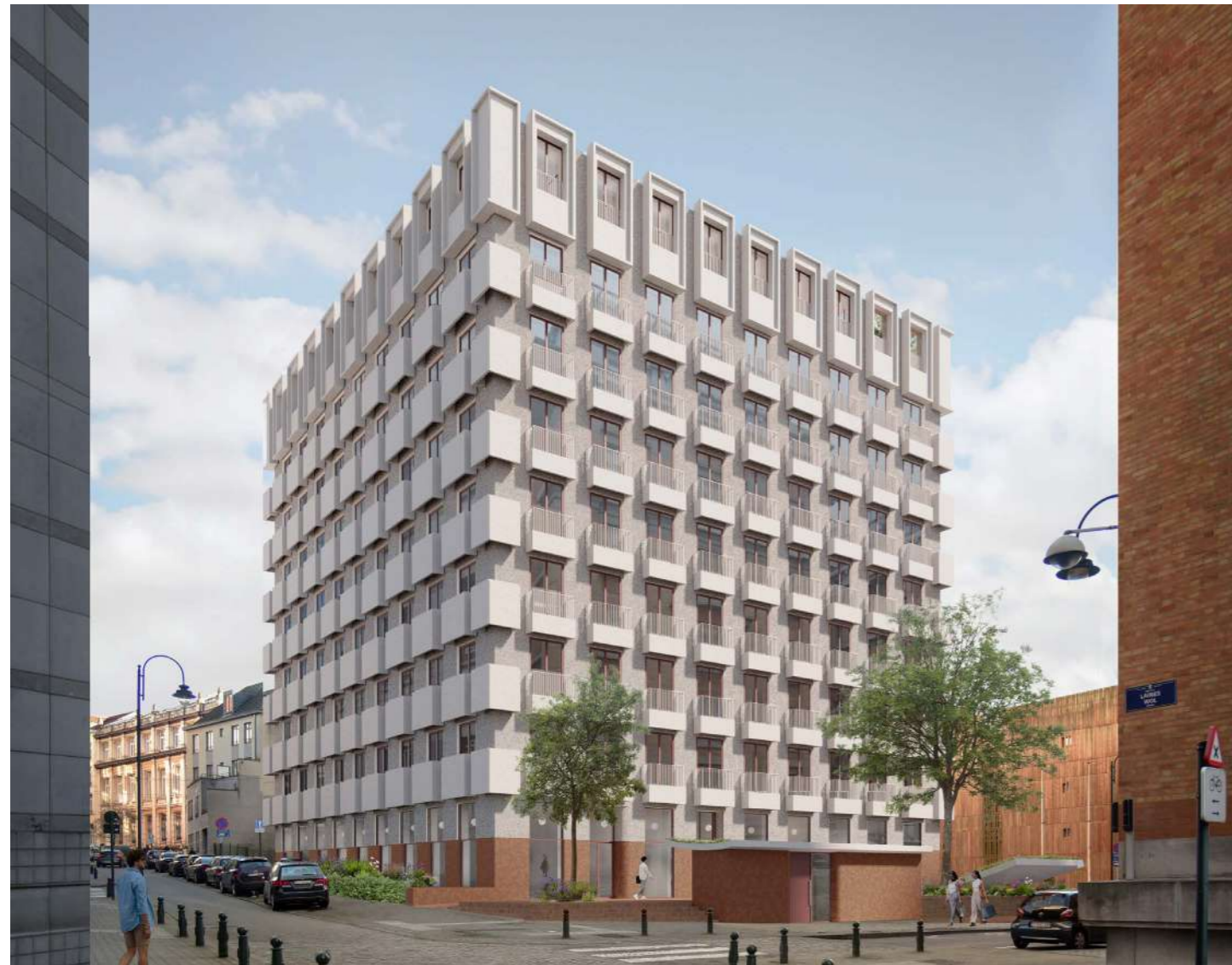
Gevelbeeld naar de Everstraat met een opengewerkte gevel en een fijn kroon
