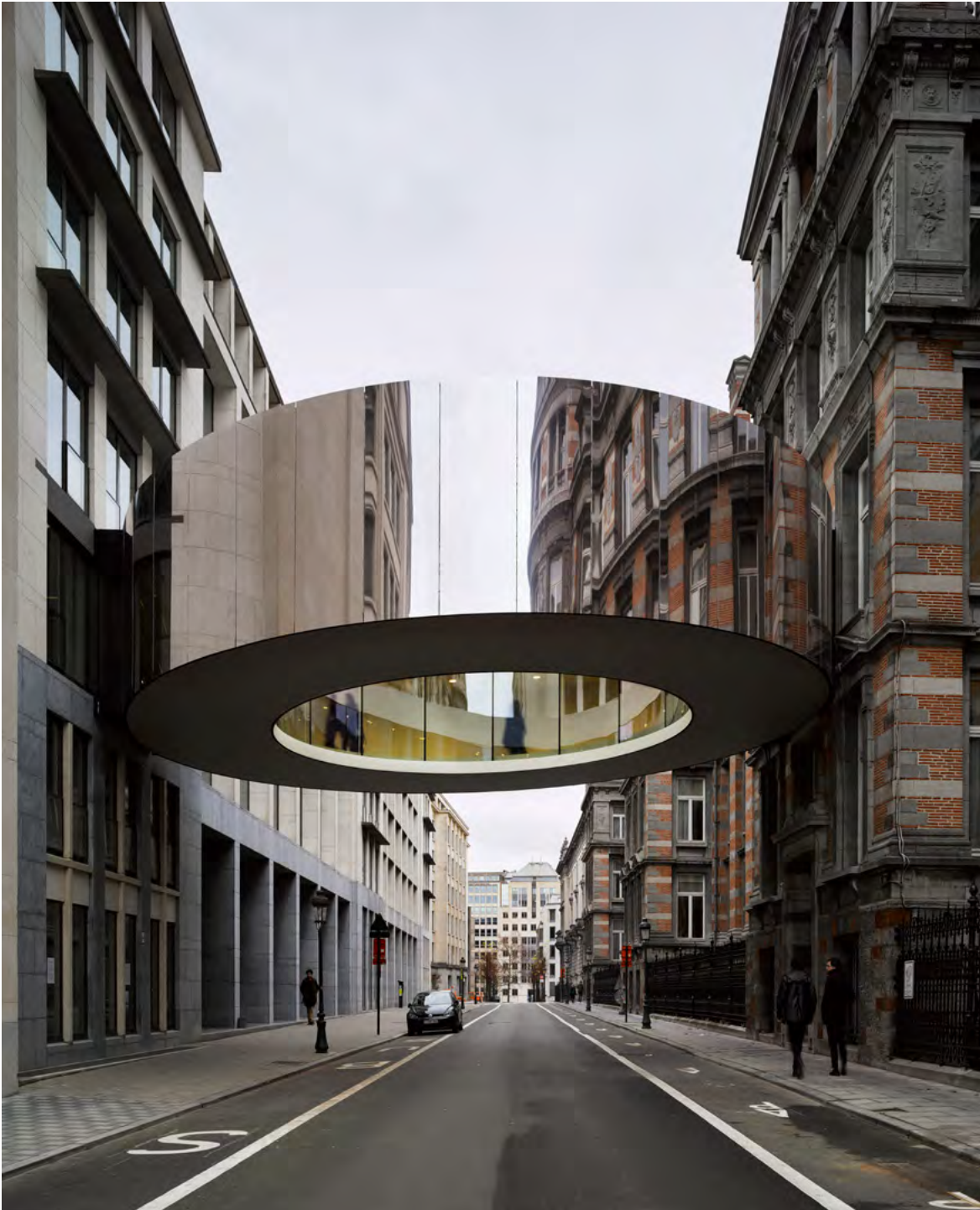
Office Kersten Geers David Van Severen, passerelle piétonne Tondo, Bruxelles, 2020 © Bas Princen
