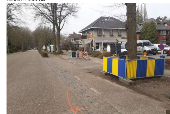
Système de protection des arbres pendant le chantier. Source : Arcadis
