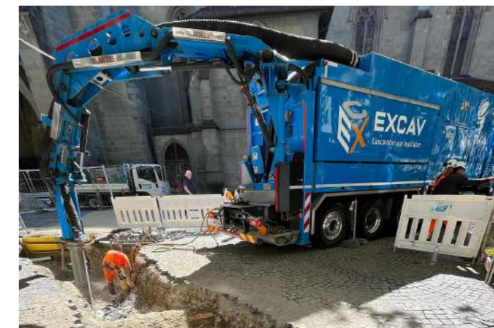
Travail par excavatrice pour protéger le système racinaire des arbres. Source : Excav SA
