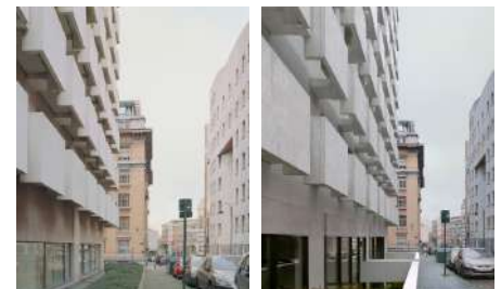
Avant-Après rue aux Laines
