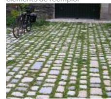
Pavés béton avec des éléments de réemploi
