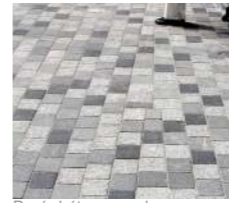
Pavés béton avec des éléments de réemploi
