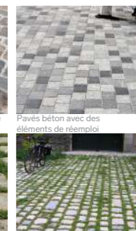
Paves béton avec des éléments de réemploi
