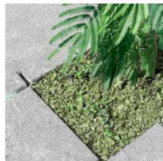
perméabilisation de surface
