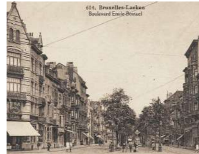
Maison de maître, berme centrale et commerce. Un boulevard exemplaire.
