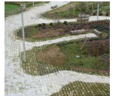
mix de revêtements en pavés récupérés
