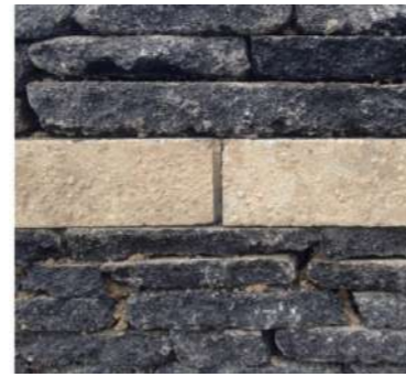
détail de mobilier urbain avec récupération d'asphalte
