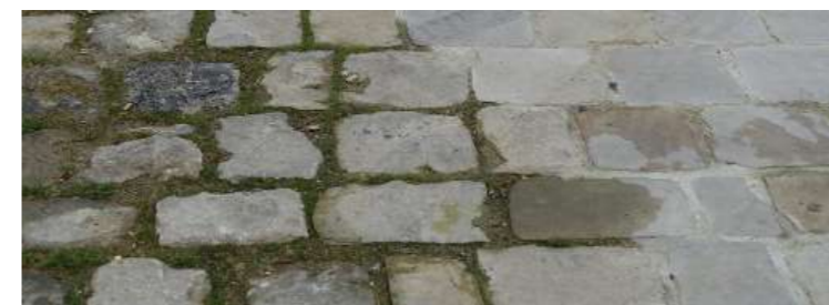
revêtement en pavés de récupération avec joints ouverts
