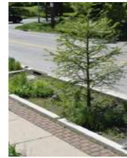
Bermes latérales d'infiltration
