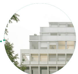
Pignon en escalier
