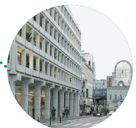
Nouvelle façade rue du Luxembourg
