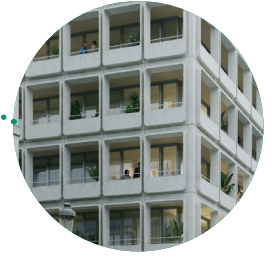
Loggias sur rue du Luxembourg
