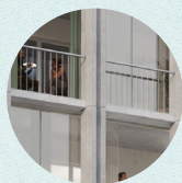
Structure en béton
