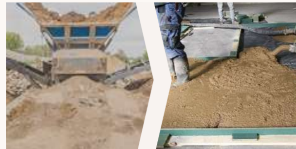
Grond uit de uitgraving verwerken in chape-ter
