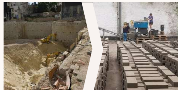
Grond uit de uitgraving verwerken in earth blocks
