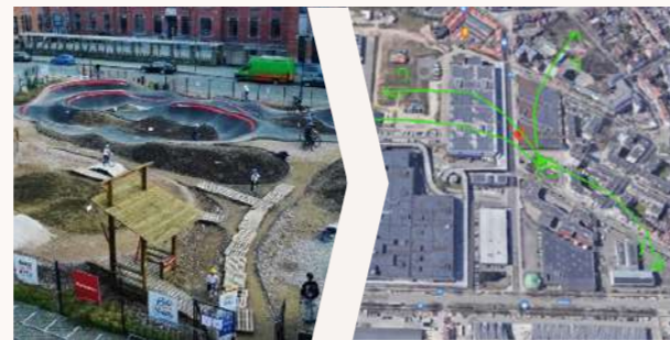
Herbruik materialen op de site - afbraak Pumptrack
