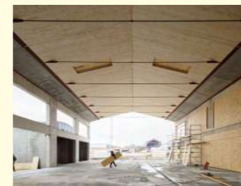
toiture en CLT
