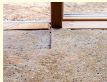
chape en terre
