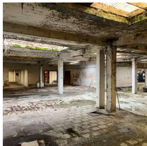
préservé les structures existantes
