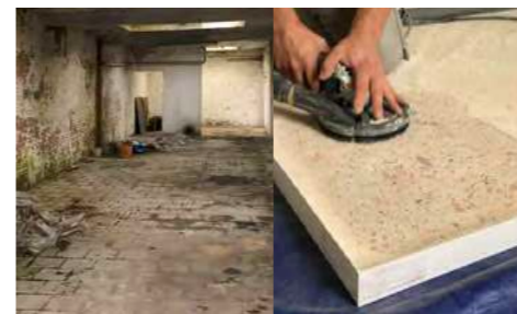
Ponçage des dalles existantes permettant de transformer un matériau banal en revêtement de finition raffiné.
