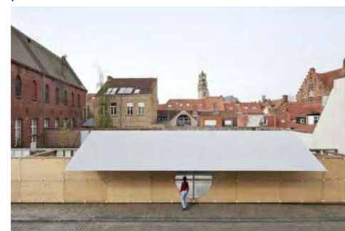
Jardins communautaires Raamlant, Bruges, Norell-Rodhe architectes
