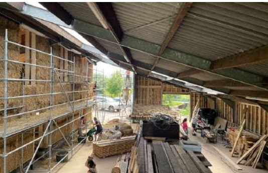
Verbouwing loods voor Natuurpunt. Bouwen met hout uit eigen bos en stro van eigen akker, Murmuur architecten.
