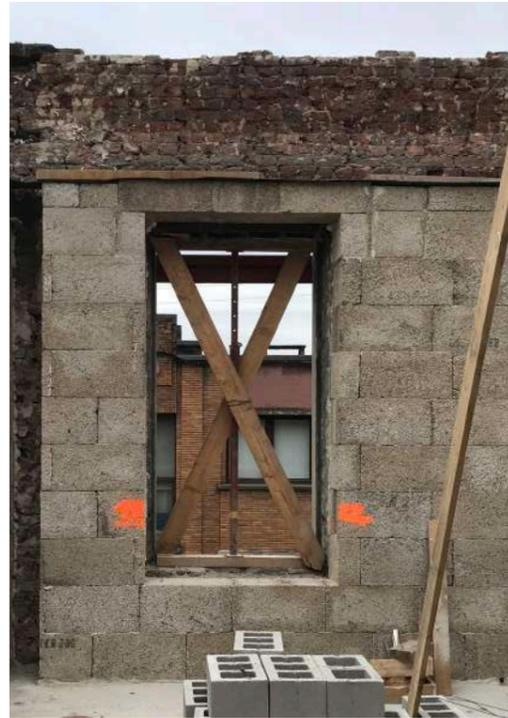
AgwA + S2JD, Wandre - isolation par l'intérieur d'un bâtiment existant avec des blocs de chanvre
