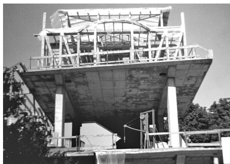
Referentie permanente betonstructuur met lichte invulling
