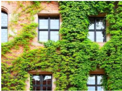
Voorbeeld voor een monumentale baksteengevel. Onderzoek heeft aangetoond dat gevelbegroeiing de levensduur van een dergelijke gevel verlengt.
