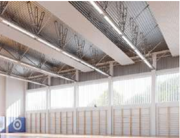
Exemples de panneaux radiants
