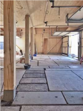
Hangar stade des Arbères - FAZ architectes, Meyrin CH
