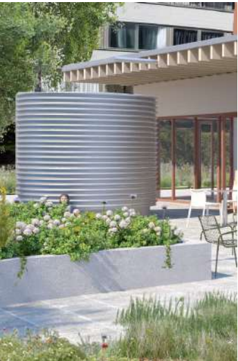
Récupération de l'eau pluvial Regenwaterreuperatie
