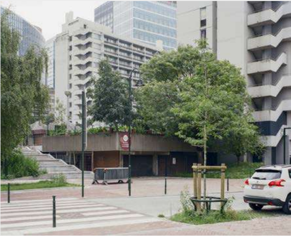
le linteau existant en béton sera récupéré pour la nouvelle façade
