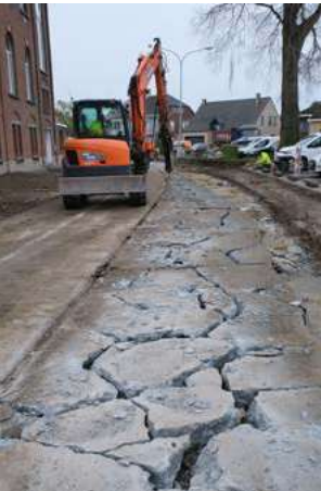
groene voegen in betonplaat
