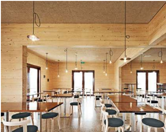
CLT draagstructuur zichtbaar in interieurs
