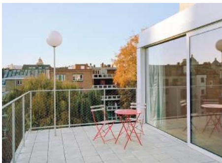
Referentie dakterras (Central)
