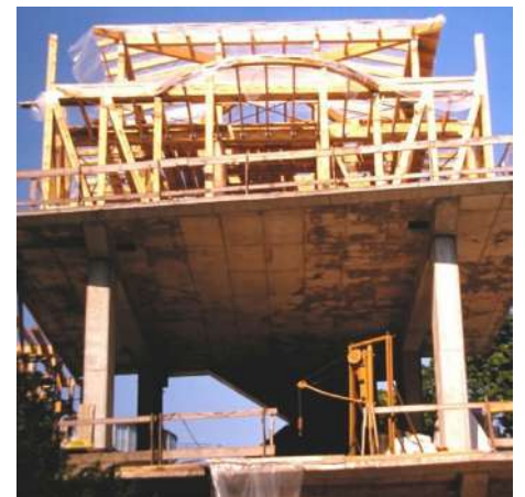
Betonnen vloerplaten hebben een groot voordeel naar thermische inertie en akoestiek. Een betonnen structuur wordt ingevuld met houtbouw invulling naar het drager-inbouwprincipe
