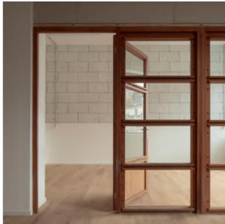
Blocs de chanvre-chaux apparent pour une solution de traitement acoustique low-cost, Brognez, Karbon'
