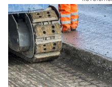
Découpage et réutilisation de l'asphalte
