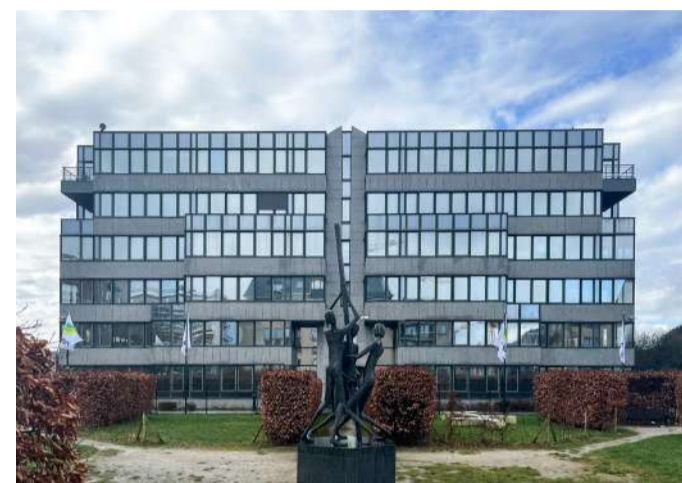
De bestaande natuurstenen gevelpanelen worden herbruikt
