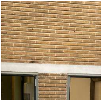
Elements de façade de la Rotonde
