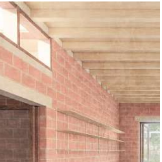
Structure visibles dans les ateliers
