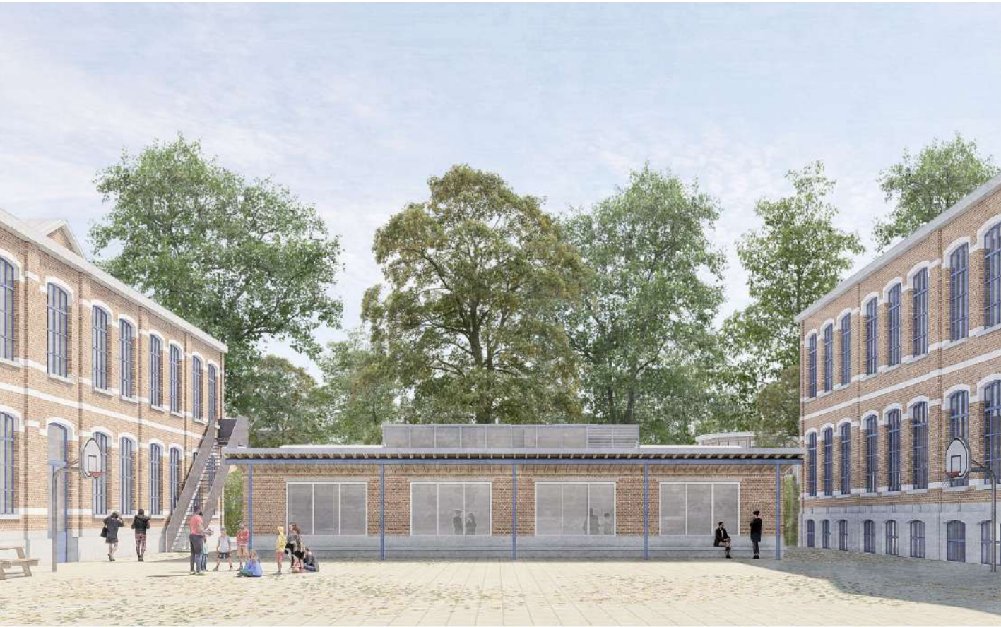
Vue sur le nouveau bâtiment du Centre de Documentations et d'Informations
