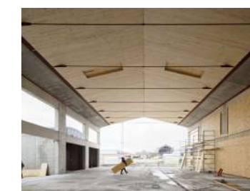
toiture en CLT
