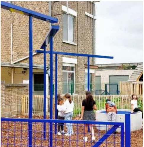
Récupération ludiques des eaux de toitures - Asiat Parc - Plant en Houtgoed
