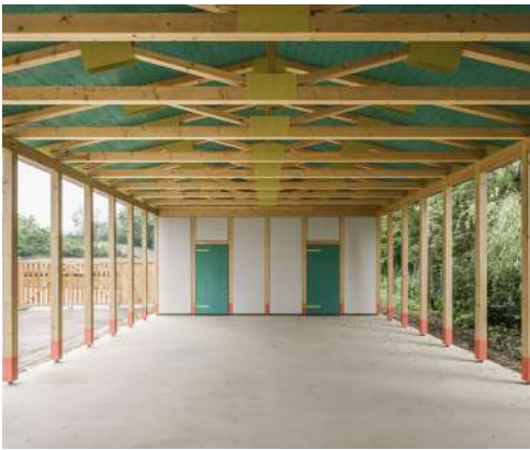
Erkläranlage Pavilion Max Otto Zitzelsberger Architekt
