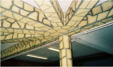
La Rotonde : beauté structurelle et matérielle Photographie originale janvier 2026
