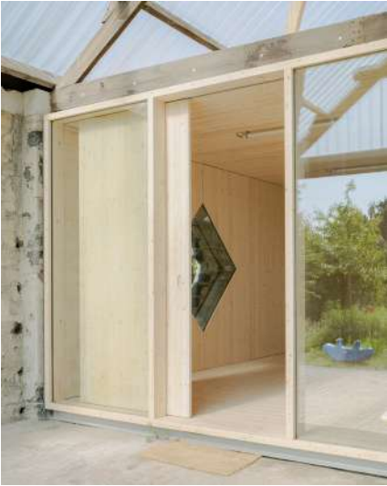
Des panneaux en bois cloués forment un espace chaleureux ACME, ateliers de l’agence, Gand, 2025
