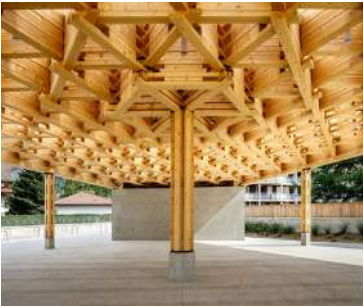
Une structure circulaire avec éléments réduits, sur plots Arborescence, Halle de Marché, Scionzier, 2022
