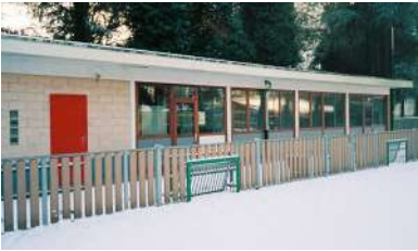
L’Annexe : le bel auvent en béton abritera les bureaux Photographie originale janvier 2026
