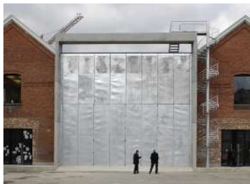
Techniques d'une école devenant centre culturel Détang, Maison Folie, Mons, 2006 (Arch. Matador)
