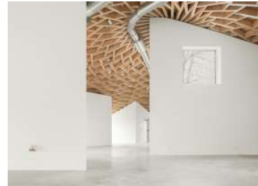
Stabilité d'une structure réciproque légère en bois, WOW, Centre F. Masereel, Kasterlee, 2019 (Arch. List)
