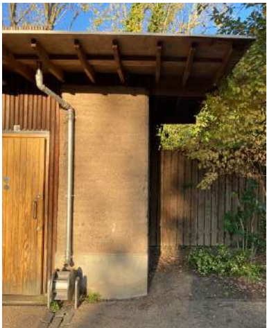
Redirection didactique des eaux de toiture sous forme de jeu - Adventure Playground Erect Architecture Londres
