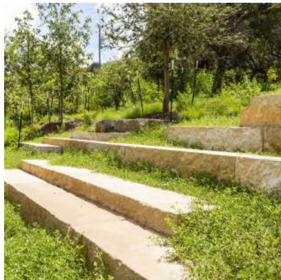
5 Pierres de récupération pour assises dans la pente
