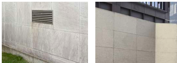
Nous évaluerons la possibilité de réemployer les parements existants pour constituer la façade du socle
