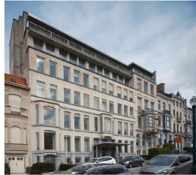
Immeuble côté Avenue Palmerston
