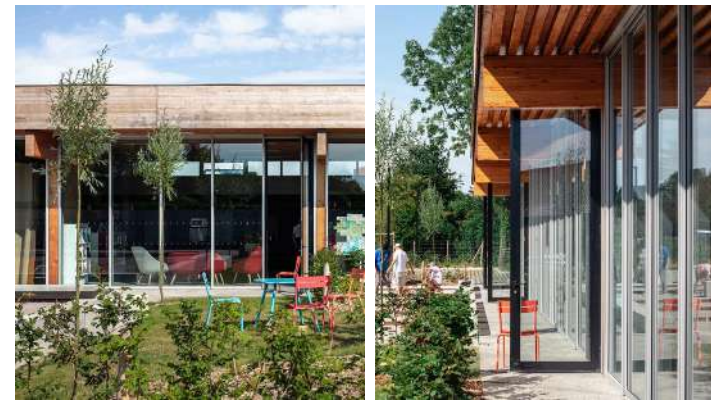
HBAAT, Médiathèque, Cappelle-en-Pévèle, 2018
