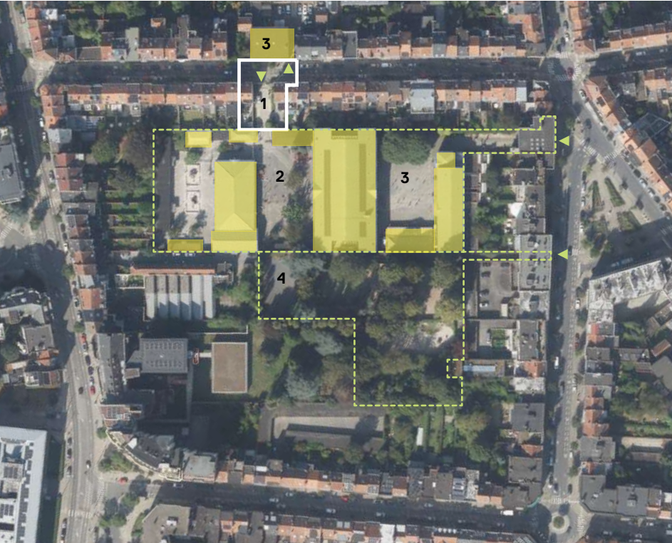
Vue aérienne de l’îlot - Bruciel 2026 ↗ Nord
