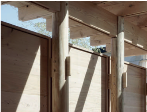
Articulation colonne et poutres bois
