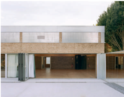
Une façade qui peut s'ouvrir complètement grâce à des portes accordéon (réf Studio Rijssel)
